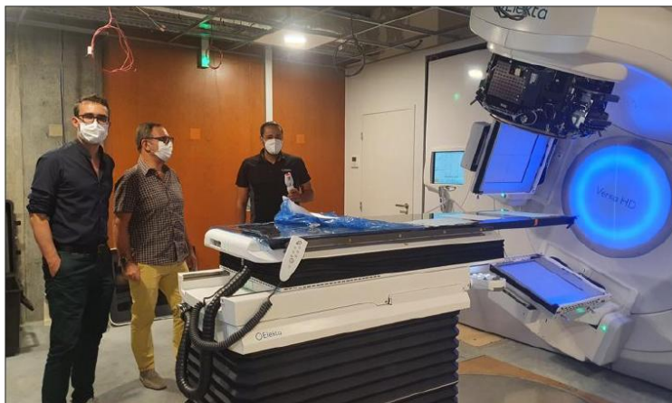
Benjamin Schipman et François Rocher, médecins, en compagnie de Fouad Djeghaba, l'ingénieur qui installe la nouvelle machine. Photo Emmanuelle VIRE SOLVIT
