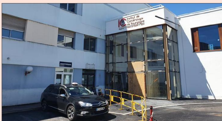
L'extension communique avec le bâtiment existant. Photo JSL/Emmanuelle VIRE SOLVIT
